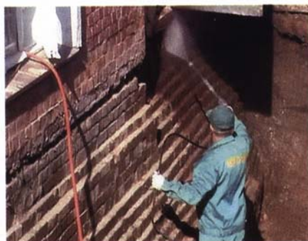
Рис. 9.7. Нанесение на поверхность стены Полиакватрона А
