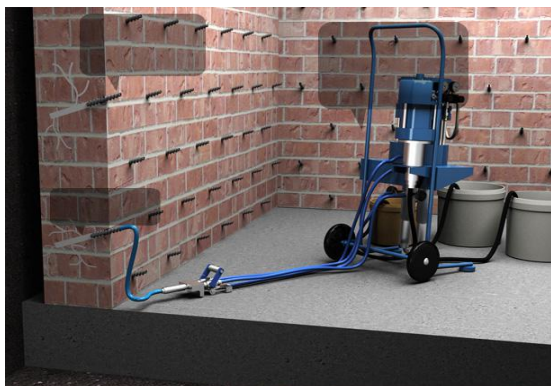
Рис. 4.8. Инъектирование в каменную или кирпичную кладку
