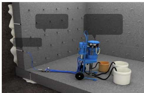
Рис. 4.9. Создание противофильтрационной завесы
