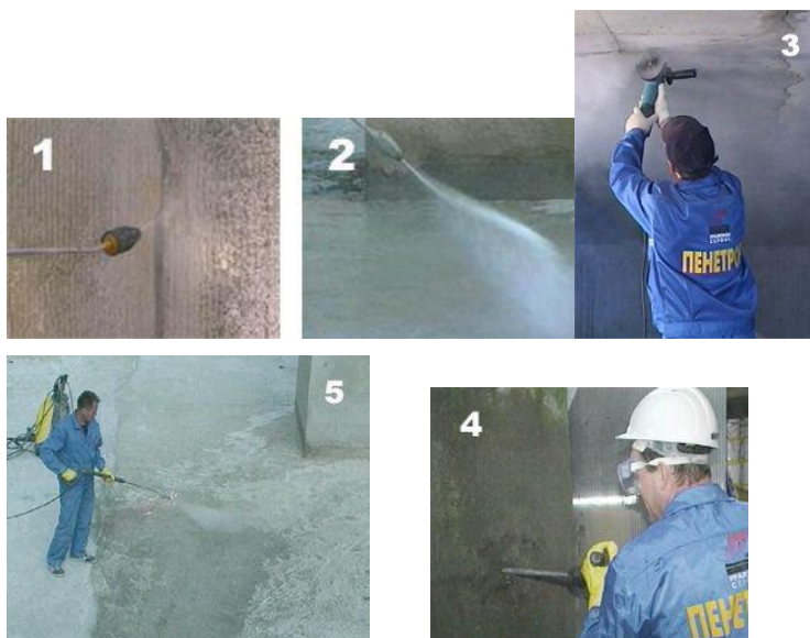
Рис. 8.2. Последовательность работ по устройству Гидроизоляции из системы Пенетрон
