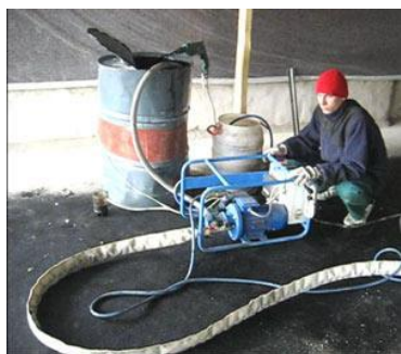
Рис. 6.5. Установка RX-27Б, в бочке – жидкая резина, в канистре - отвердитель
