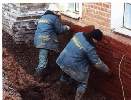
Рис. 9.6. Подготовка к работе по нанесению Полиакватрона А
