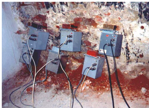
Рис. 2.9. Микроволновое осушение стены с применением штырьковых антенн
