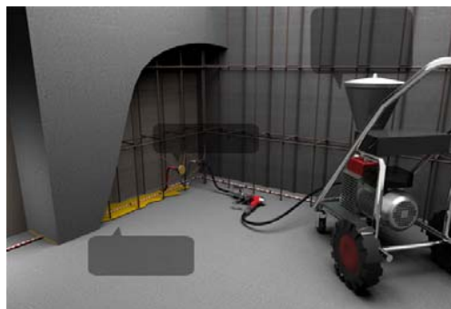
Рис. 4.4. Установка герметика при герметизации рабочих швов бетонирования
