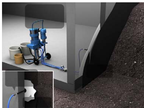
Рис. 4.6. Гидроизоляция поврежденных мембран
