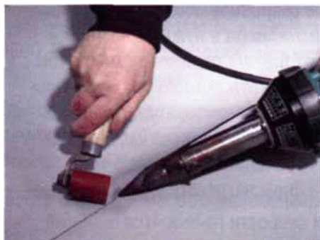
Рис. 10.7. Сварка ручным аппаратом
