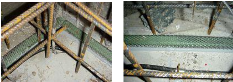
Рис. 7.5. Установка гидропрокладок Бентострип в рабочих швах бетонирования
