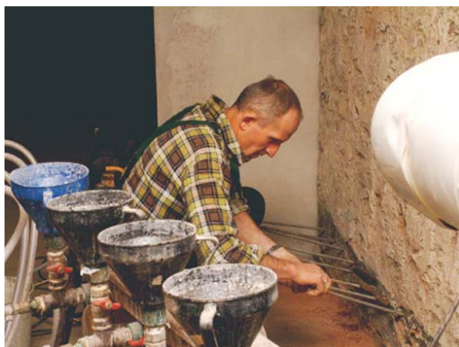
Рис. 2.5. Закачивание в отверстия высушенной стены гидрофобного раствора
