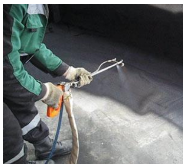
Рис. 6.6. Напыление покрытия двухканальным распылителем
