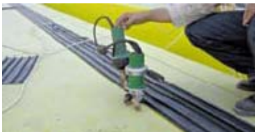
Рис. 4.12. Крепление мембраны к закладным пластиковым ронделям горячим воздухом
