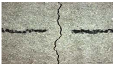
Рис. 9.1. Трещина в теле бетона шириной 0,1-0,4 мм, образовавшаяся в процессе эксплуатации объекта, на который был нанесен Carat
