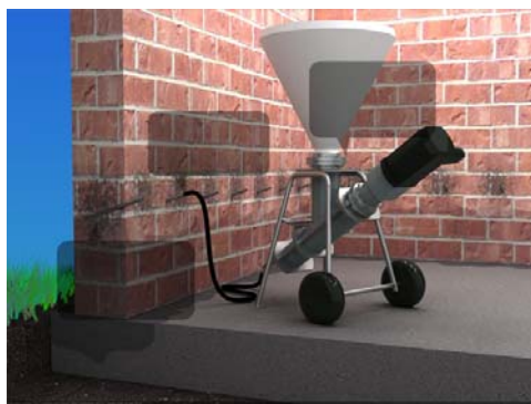
Рис. 4.7. Создание отсечной гидроизоляции
